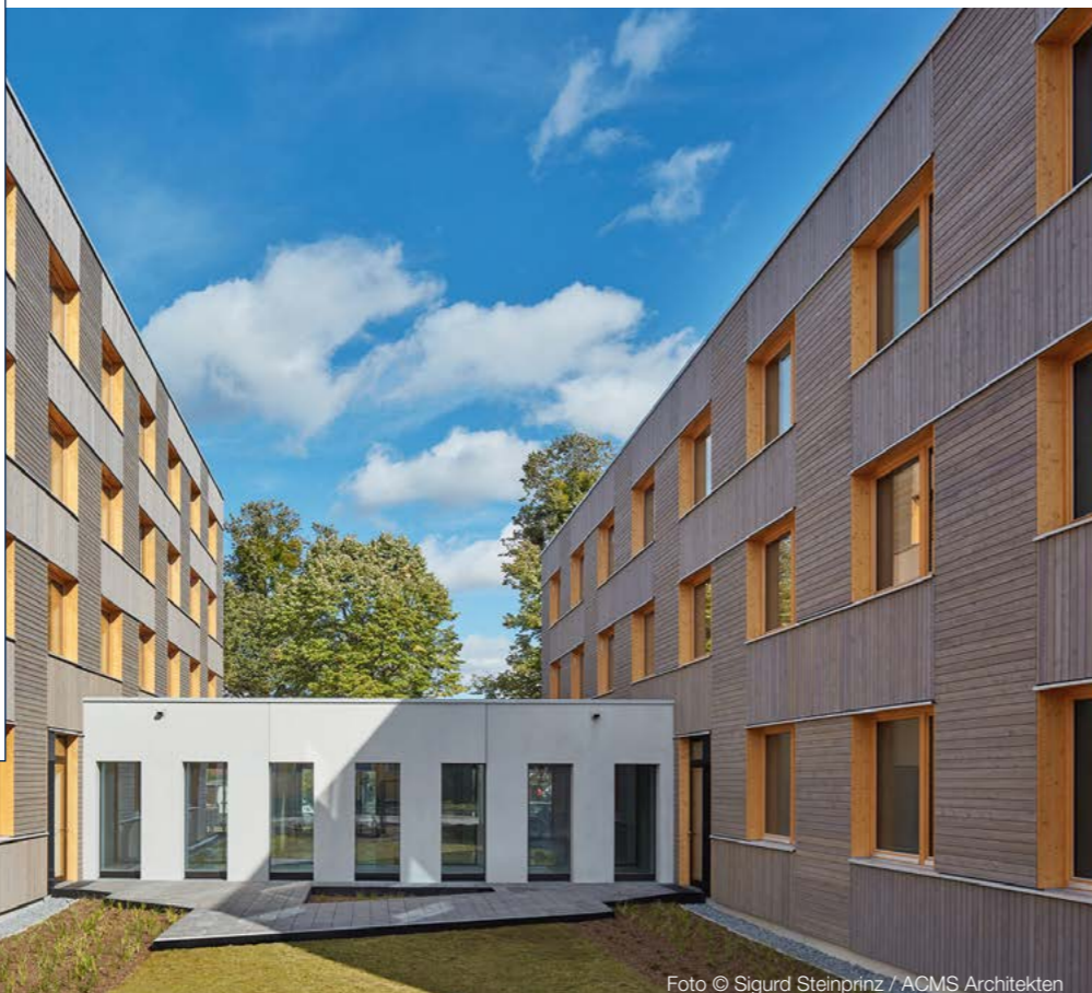
Foto © Sigurd Steinprinz / ACMS Architekten
