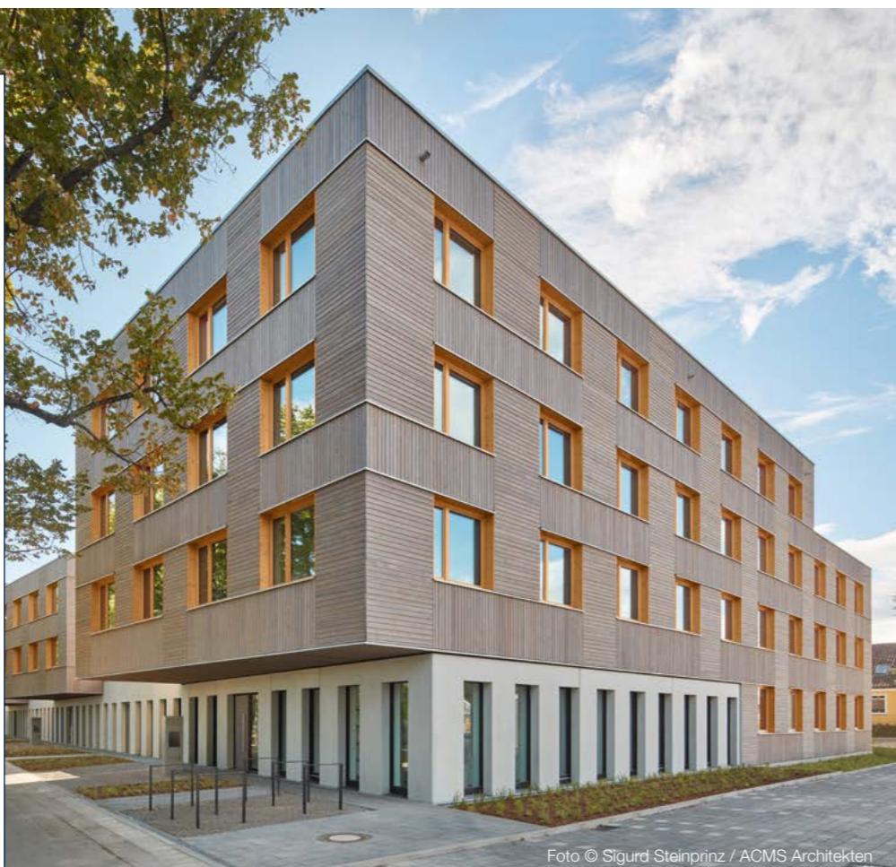
Foto © Sigurd Steinprinz / ACMS Architekten
